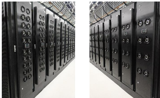
图 5.14 热管背板机柜照片
