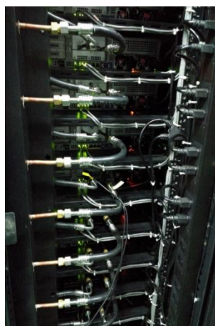
图 5.18 双级回路热管冷却系统照片
