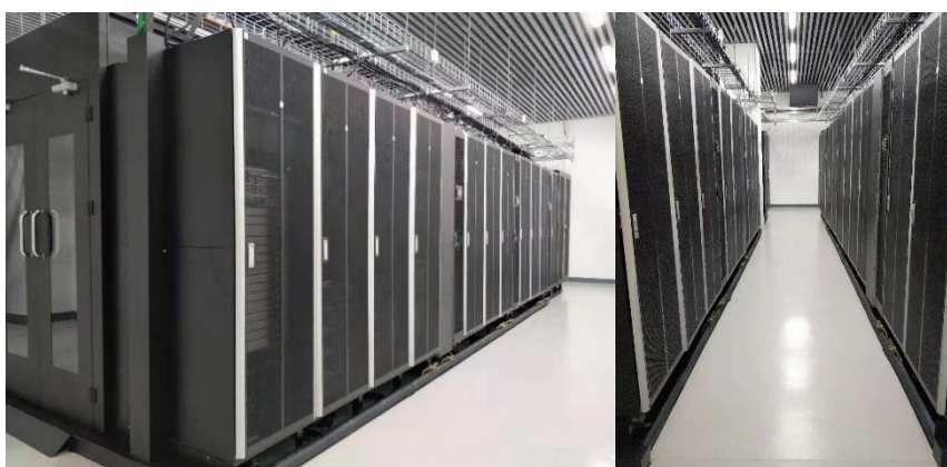
图 5.7 列间空调冷却系统照片
