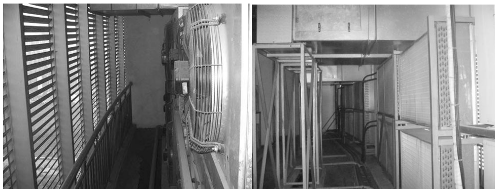
室外机安装实景
