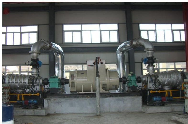
西藏羊八井地热蒸汽和汽水两相螺杆膨胀发电机组
