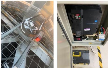
图 12 风机变频控制水温稳定
