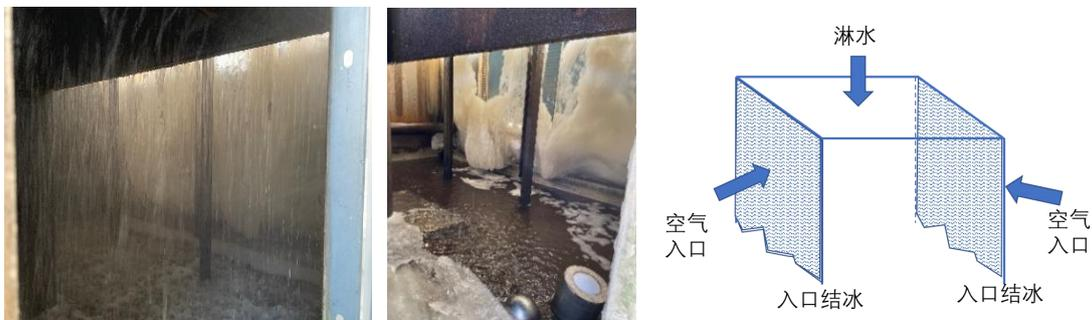
图 7. 冷却塔空气入口结冰现象
