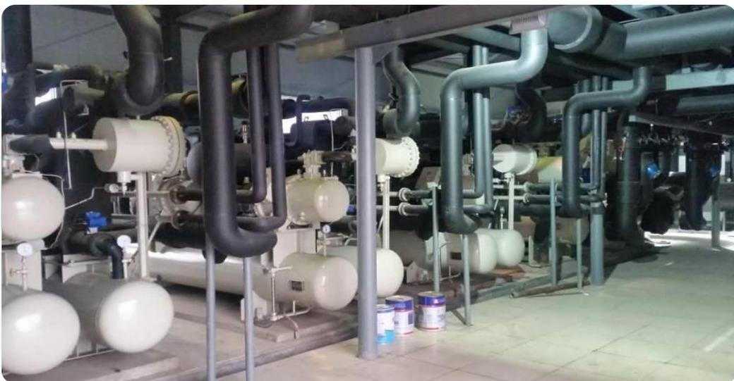
**深焓取热：**热泵多级（四级）取热，深度提取乏风焓差，制取热水；
